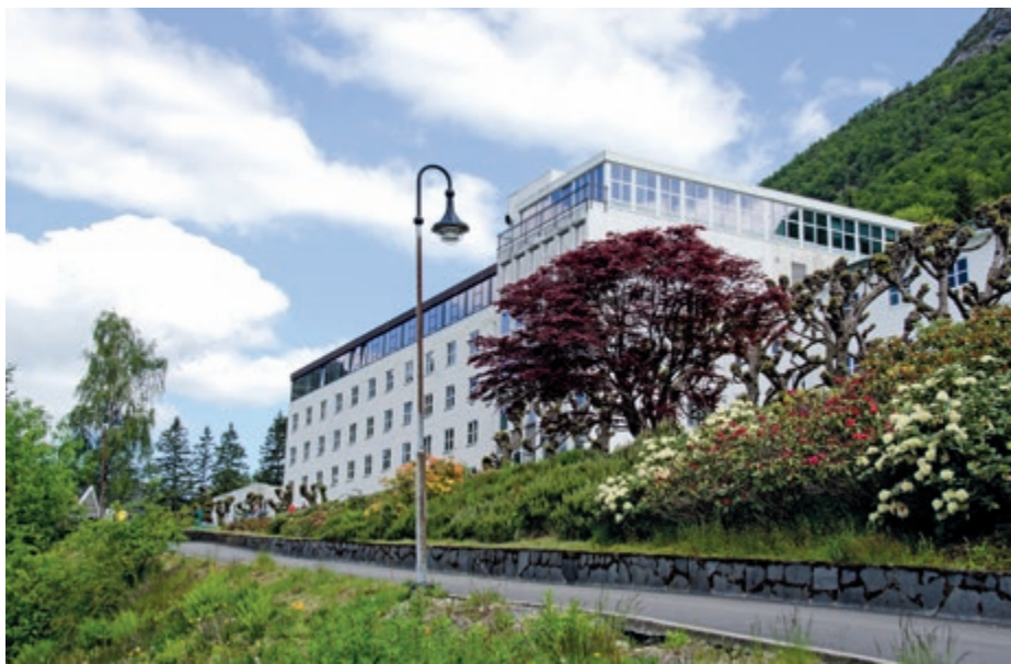
Haraldsplass Diagonale Sykehus (HDS) er lokalsykehus for ca. 120 000 innbyggere i ni kommuner i Nordhordland samt bydelene Arna, Bergenhus og Åsane i Bergen kommune.
