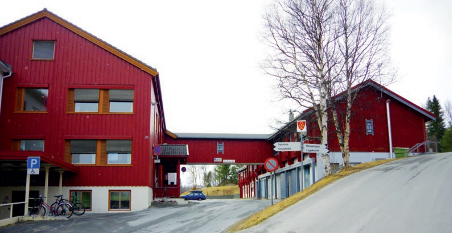
Gangbroen mellom sykehuset – som rommer EEO – og legekantoret på Røros har både praktisk og symbolsk betydning. FOTO: HEGE LILJEDAHL STEENE
