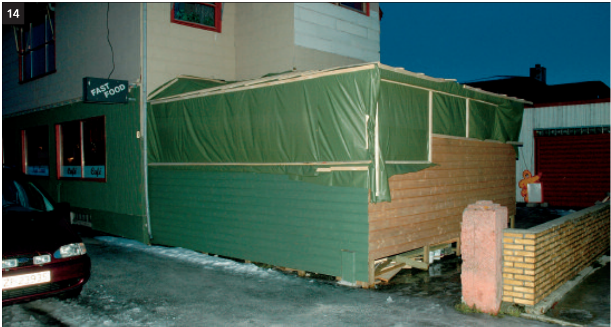
En av restaurantene i Andøy har valgt en noe radikal løsning på problemet med vinterkulde og røykesugne gjester. Restauranten har fått pålegg fra kommunen om å fjerne overbygget. Saken har ikke blitt behandlet av kommunehelsetjenesten, men av teknisk avdeling som et brudd på byggeforskriften. Restauranteieren nekter å fjerne overbygget og har sagt at han vil påklage vedtaket. (1) FOTO: JØRN AUNE
